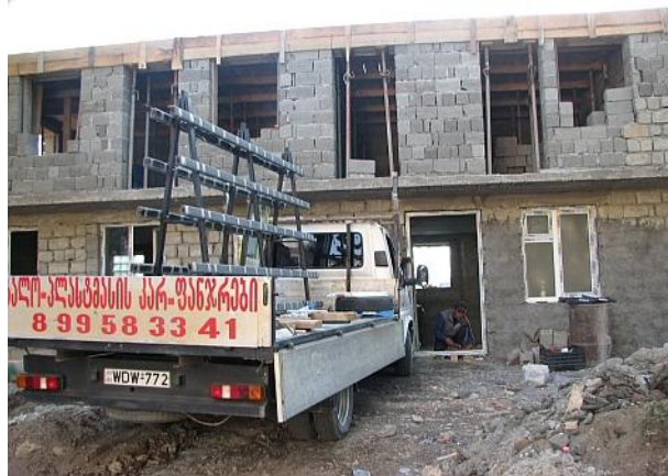
Строительство сыроварни и гостиницы в Телави
